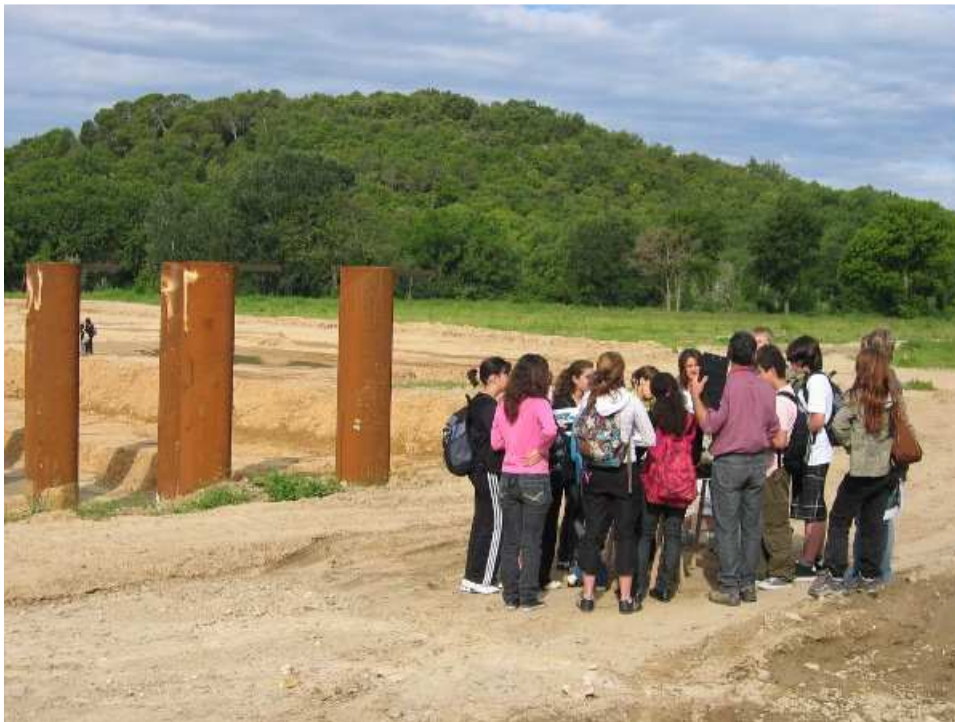
Collège de Lunel en visite sur le chantier du peigne à embâcles
